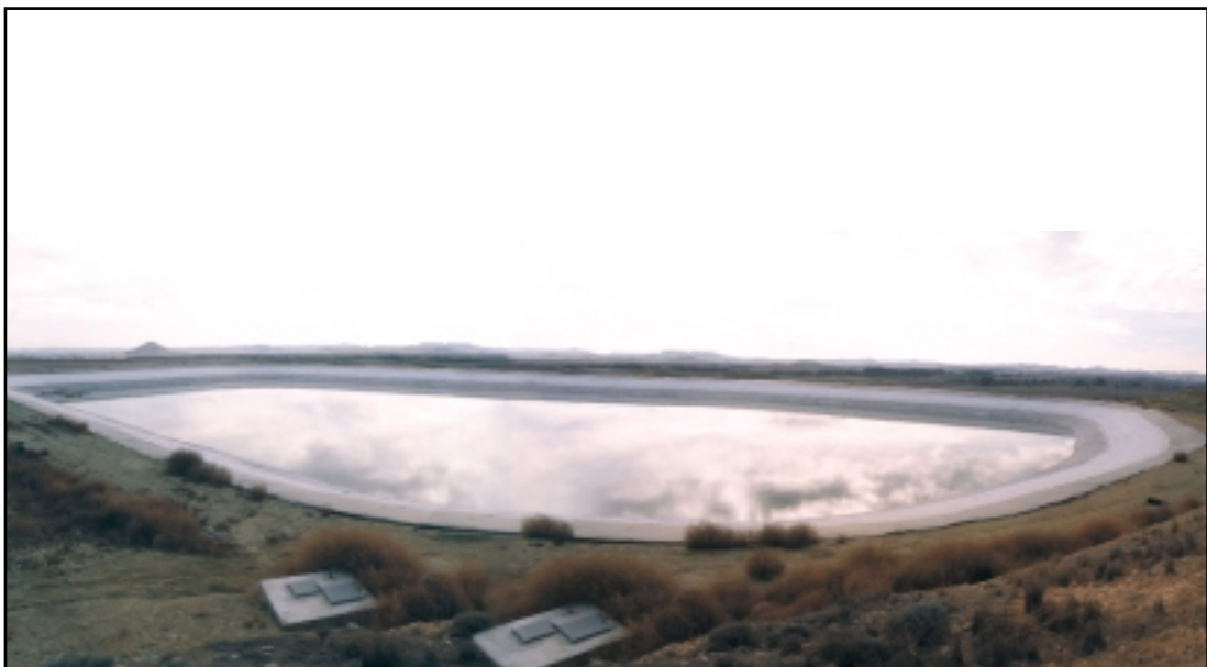
Δεξαμενή αποθήκευσης ανακυκλωμένου νερού
