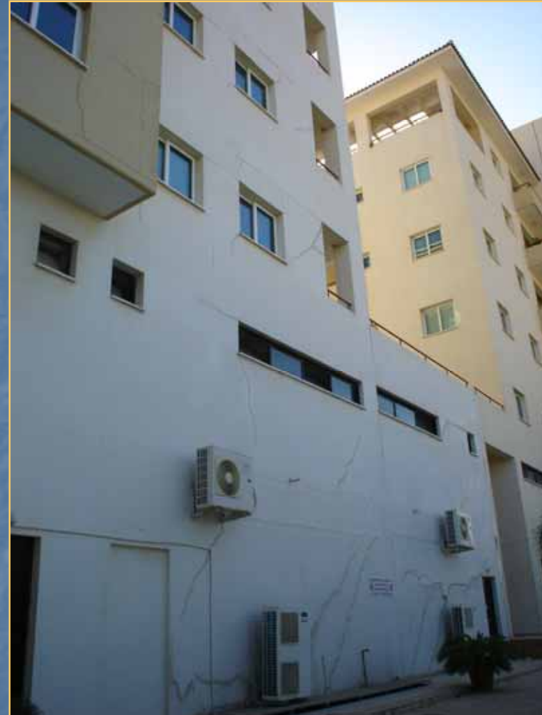
Χαρακτηριστική μορφή ρωγματώσεων σε κτίρια
