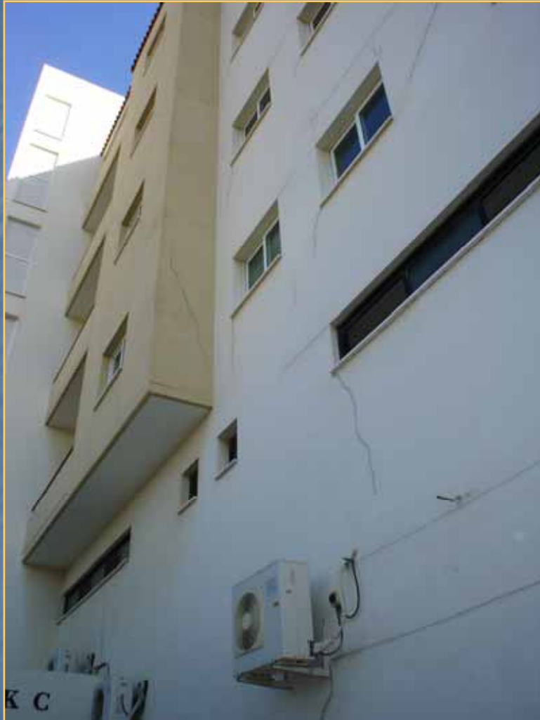
Χαρακτηριστική μορφή ρωγματώσεων σε κτίρια
