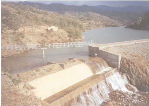
Φράγμα Αργάκας (1964) (Φώτο: Αρχείο Τμήματος Αναπτύξεως Υδάτων)
