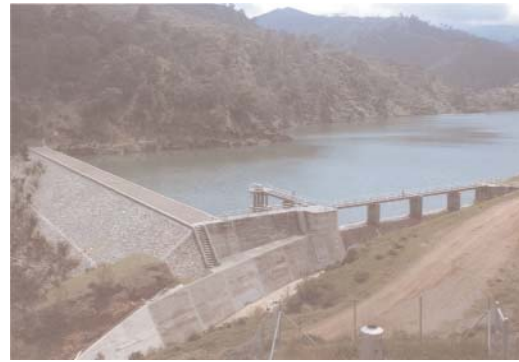
Φράγμα Πωμού (1966) (Φώτο: Αρχείο Τμήματος Αναπτύξεως Υδάτων)
