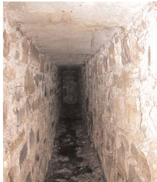
Πετρόκτιστο υπόγειο κανάλι λαουμιού. (Φώτο: Αρχείο Τμήματος Αναπτύξεως Υδάτων)
