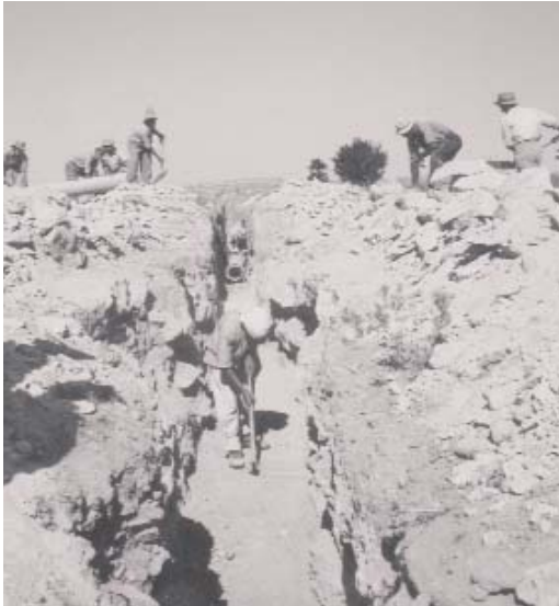
Τοποθέτηση αγωγού στη Λευκωσία (Φώτο: Αρχείο Γραφείου Τύπου και Πληροφοριών)
