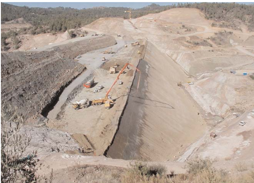
Φράγμα Κανναβιού (υπό κατασκευή) (Φώτο: Αρχείο Τμήματος Αναπτύξεως Υδάτων)
