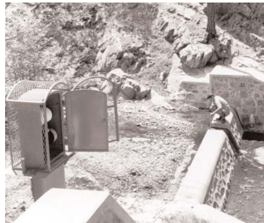
Μέτρηση ροής νερού (Φώτο: Αρχείο Τμήματος Αναπτύξεως Υδάτων)
