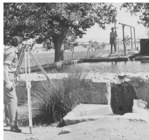
Υπομέτρηση από τον Κλάδο Τοπογραφίας του Τμήματος Αναπτύξεως Υδάτων στην Κοκκινотριμιθιά (Φώτο: Αρχείο Γραφείου Τύπου και Πληροφοριών)
