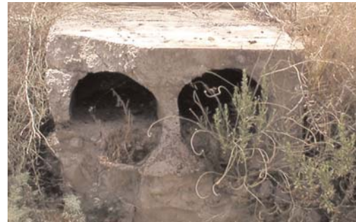
Υπόγειοι κτιστοί αγωγοί που μετέφεραν το νερό από τα “λαούμια” στα πέτρινα υδραγωγεία για υδροδότηση της πόλης της Λάρνακας (Φώτο: Αρχείο Τμήματος Αναπτύξεως Υδάτων)
