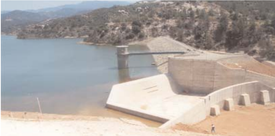
Φράγμα Αρμίνου (Φώτο: Αρχείο Τμήματος Αναπτύξεως Υδάτων)
