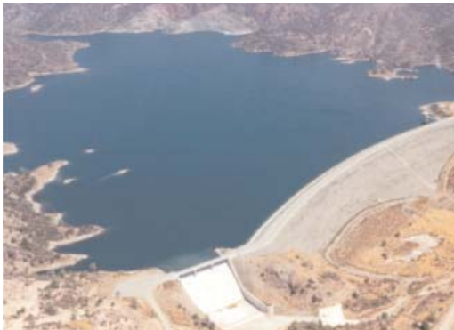
Σχέδιο Βασιλικού - Πεντάσχοιου. Φράγμα Καλαβασού (Φώτο: Αρχείο Τμήματος Αναπτύξεως Υδάτων)
