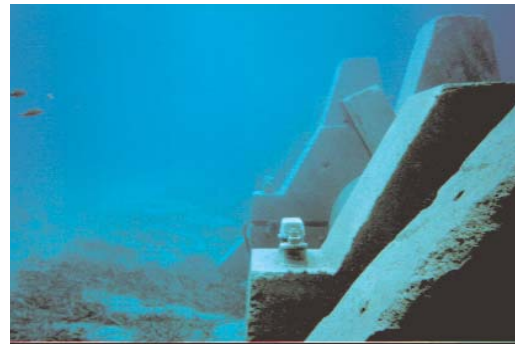
Τοποθέτηση σωληναγωγών στη θάλασσα κατά την εκτέλεση των κατασκευαστικών έργων της μονάδας αφαλάτωσης Λάρνακας (Φώτο: Αρχείο Τμήματος Αναπτύξεως Υδάτων)
