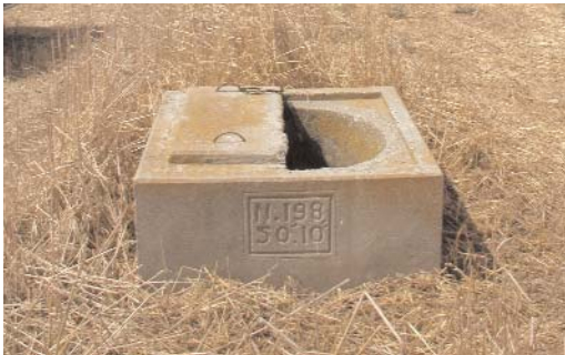
Όψη φρεατίου από μίαν αλυσίδα φρεατίων για υδροδότηση της πόλης της Λάρνακας (Φώτο: Αρχείο Τμήματος Αναπτύξεως Υδάτων)
