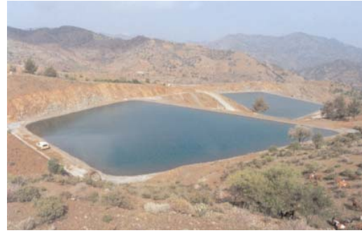
Σχέδιο Ενιαίας Αγροτικής Ανάπτυξης Πιτσιλιάς. Δεξαμενές Φαρμακά 1&2 (Φώτο: Αρχείο Τμήματος Αναπτύξεως Υδάτων)
