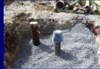
Τοποθέτηση χαλκόφιλτρου
