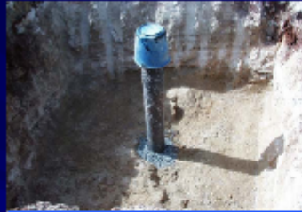
Σωληνωμένη γεώτρηση με όρυγμα
