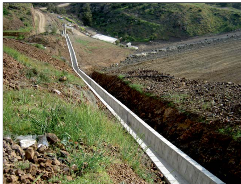
General view of spillway - Γενική όψη υπερχειλιστή
