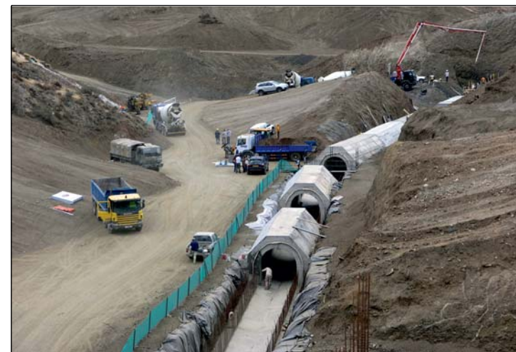
Κατασκευή οχετού εκτροπής - Diversion culvert under construction
