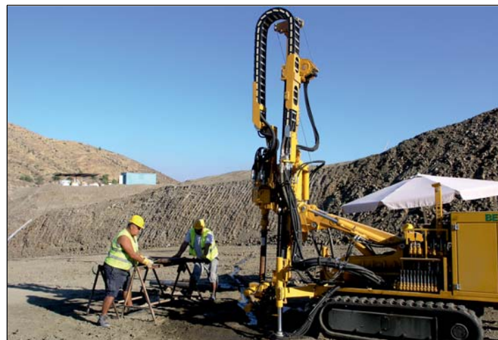
Τσιμεντένσεις στη θεμελίωση του φράγματος - Grouting of dam foundation
