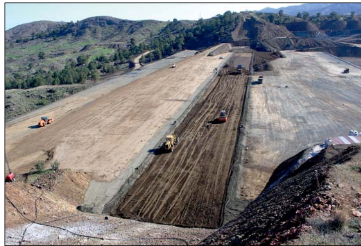
Κατασκευή αναχώματος - Construction of embankment
