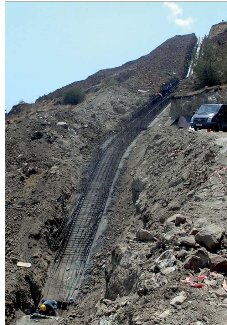
Υπερχειλιστής υπό κατασκευή - Spillway under construction
