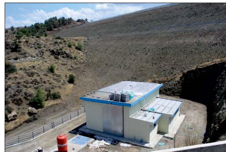
Αντλιοστάσιο κατάντη του φράγματος - Pumping station downstream of dam
