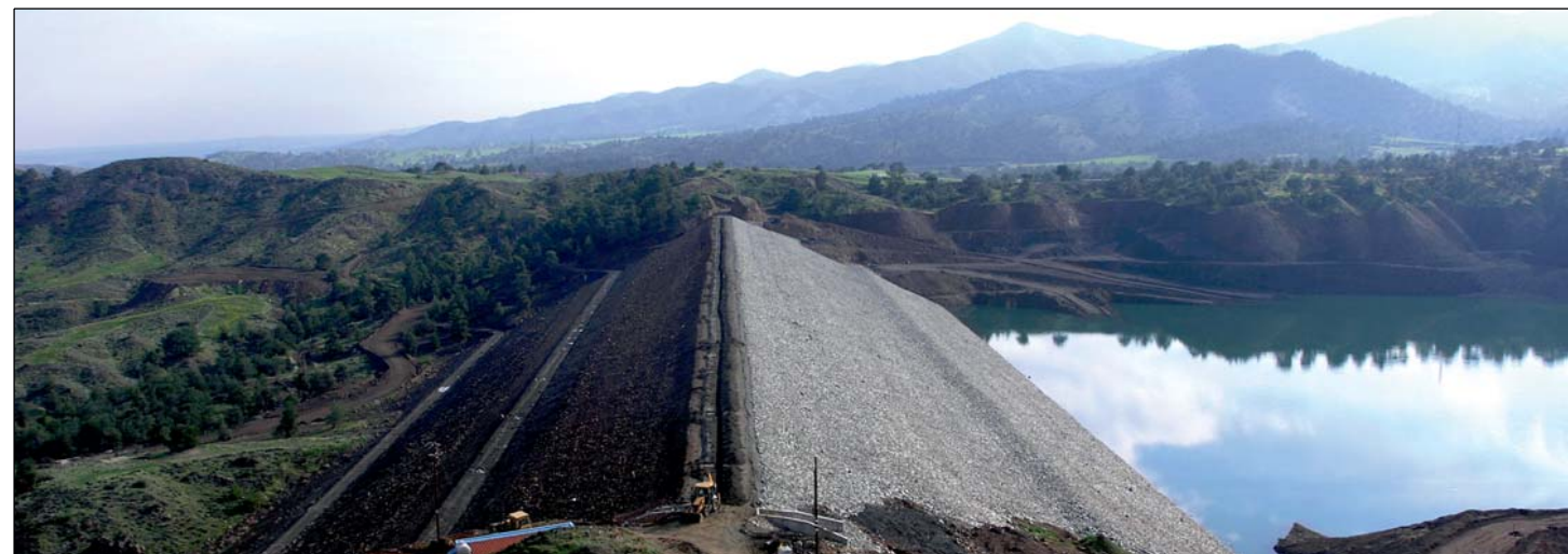
Γενική άποψη του φράγματος και του αναχώματος - General view of dam and embankment
