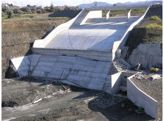
Γενική όψη υπερχειλιστή και έργα υδροληψίας
