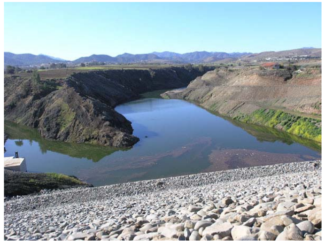
Όψη λεκάνης του φράγματος
