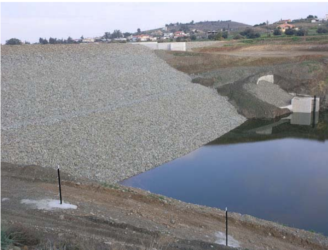
Ανάντη όψη φράγματος και έργα υδροληψίας
