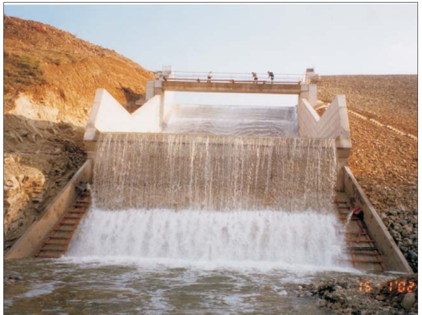
Υπερχείλιση του φράγματος - Overspilling of dam
