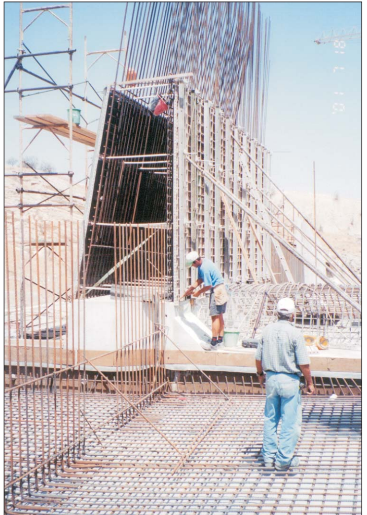
Υπερχειλιστής υπό κατασκευή - Spillway under construction
