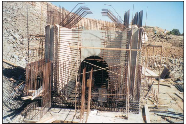
Κατασκευή έργων υδροληψίας - Intake structure under construction
