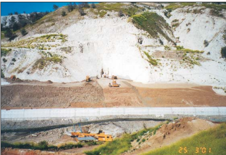
Κατασκευή αναχώματος (αριστερό αντερείσμα) - Embankment works (left abutment)
