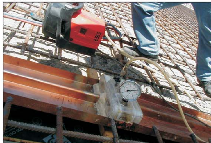
Έλεγχος στεγανότητας αρμού- Testing of copper waterstop braze
