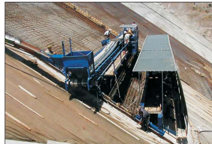
Σκυροδέτηση ανάντη πλάκας -Concreting of upstream face slab
