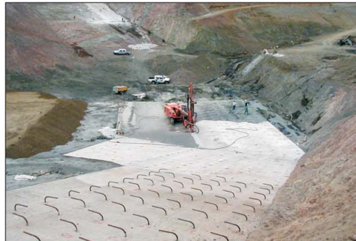
Αγκυρώσεις στη βάση της πλίνθου - Anchors at the plinth's foundation
