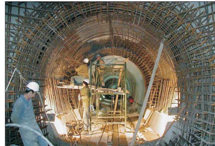
Οπλισμός στη βάση του πύργου υδροληψίας - Reinforcement at the base of the intake tower
