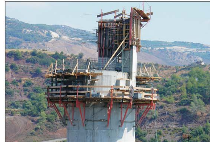
Κατασκευή πύργου υδροληψίας - Construction of intake tower
