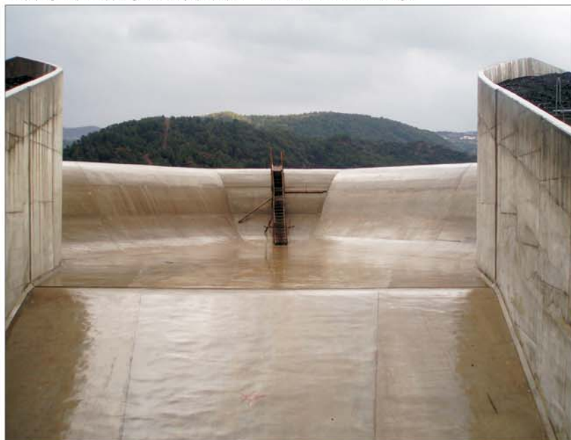
Στέψη υπερχειλιστή - Spillway weir crest
