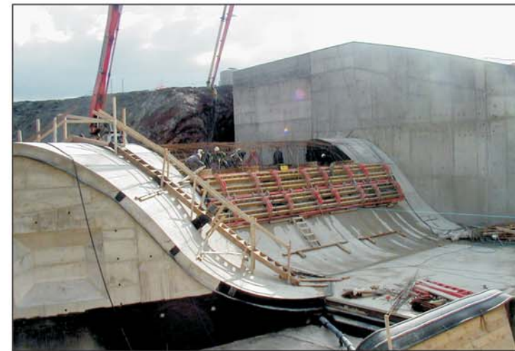
Κατασκευή υπερχειλιστή - Spillway construction
