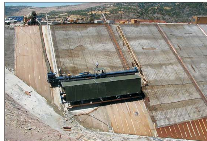
Αυτοαναρριχόμενο καλούπι σκυροδέτησης ανάντη πλάκας - Self climbing shutter for upstream face concreting
