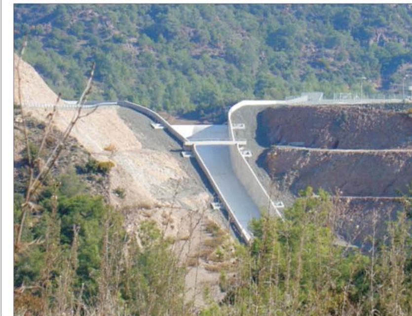
Γενική όψη υπερχειλιστή - General view of spillway
