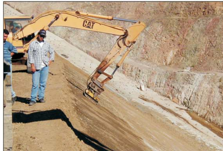
Συμπύκνωση υλικών ανάντη όψης - Compaction of upstream face
